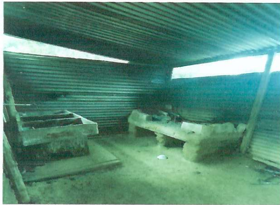
Foto1: Mejoramiento de paredes, cambio de poyetón con su extracción de humo, puerta, balcón y techo de lámina troquelada calibre 26 de la cocina.
