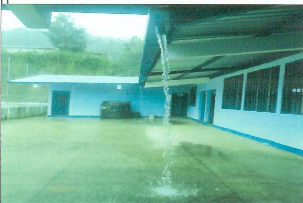
Foto 3: Instalación de bajadas de agua pluvial con tubería de metal, de los módulos, dirección, bodega y baños.
