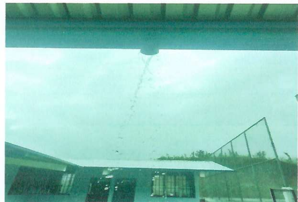
Foto 4: Instalación de techo con estructura de metal tipo pórtico con cubierta de lámina troquelada calibre 26, para el patio.
